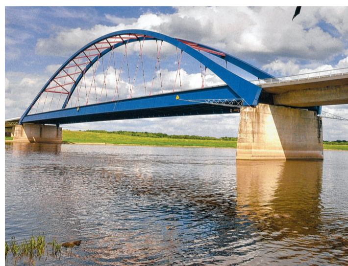
Die Dömitzer Elbestraßenbrücke nach ihrer Fertigstellung. Foto: Festung Dömitz
